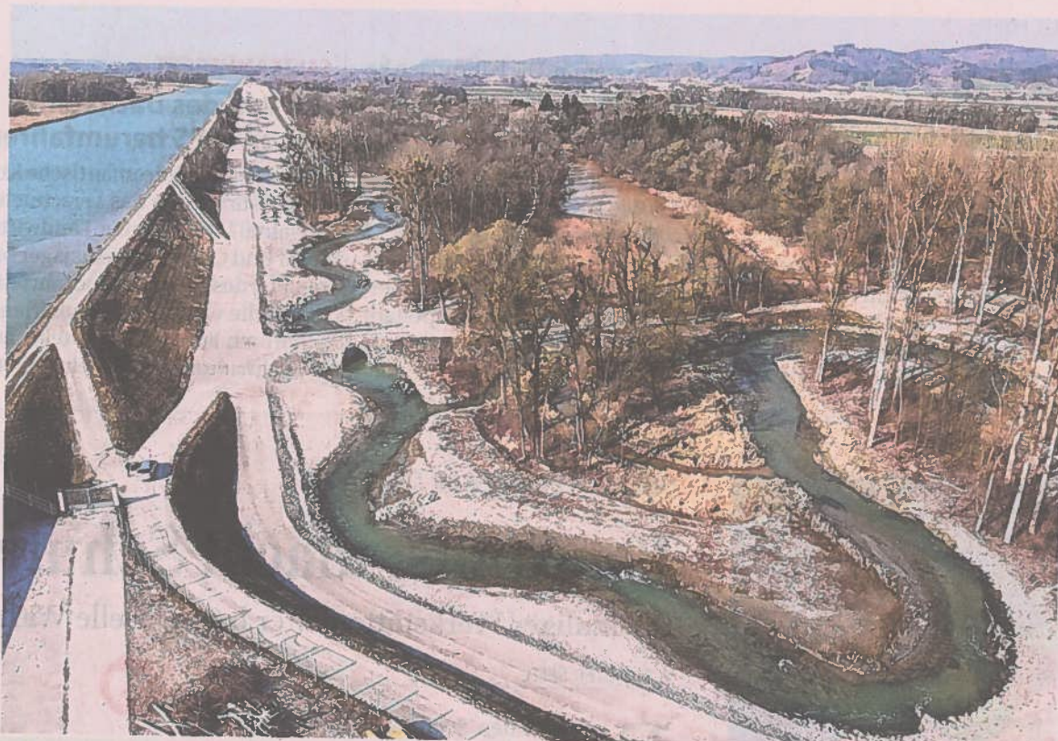
Beim innviertlerisch-bayerischen Innkraftwerk Frauenstein ist eine „Umgehung“ bereits umgesetzt. Fotos: Verbund/OÖN
