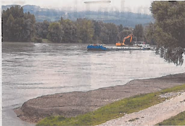
Die Arbeiten auf Höhe Winterhafen
