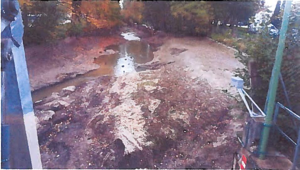
Der Mühlbach wird heuer wieder fast trockengelegt. Bild: privat
