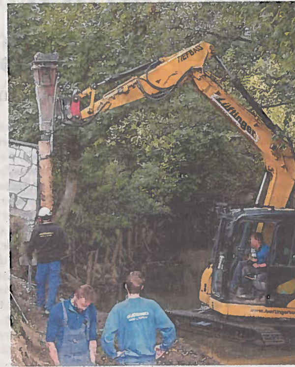
Baggerarbeiten im Bachbett.
