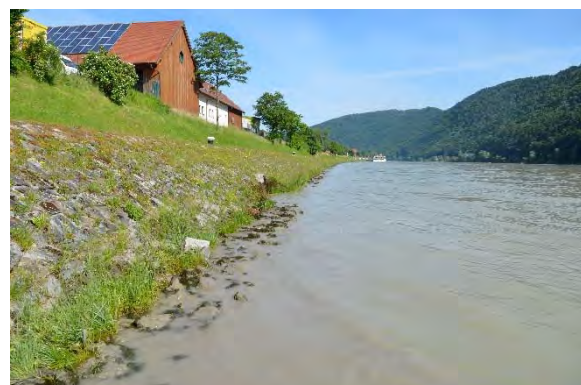
Abbildung 13: Donau im Untersuchungsgebiet Engelhartzell am 15.6.2021. Links: eingestaute Vegetation auf einer geschütteten Kiesbank; rechts: überströmte Berme an der Schifffahrtslande. Abfluss: 1.840 m 3 /s.
