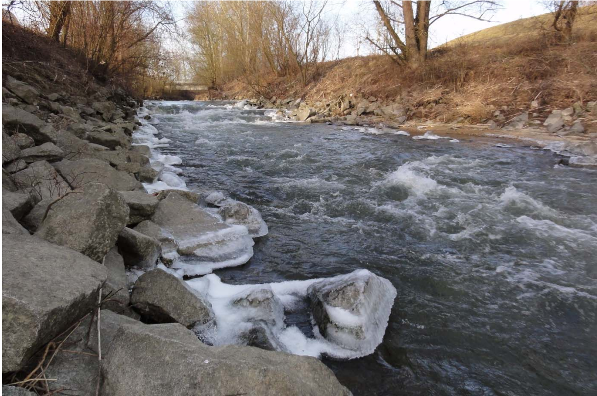
Abbildung 1: Die Rampe 400 m stromauf der Mündungsstrecke der Rodl vor Umsetzung des Projekts.
